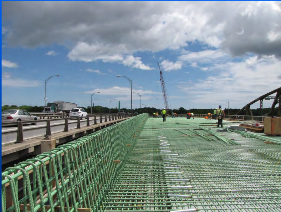
Deck Reinforcing Steel and Concrete Pour (2012)
